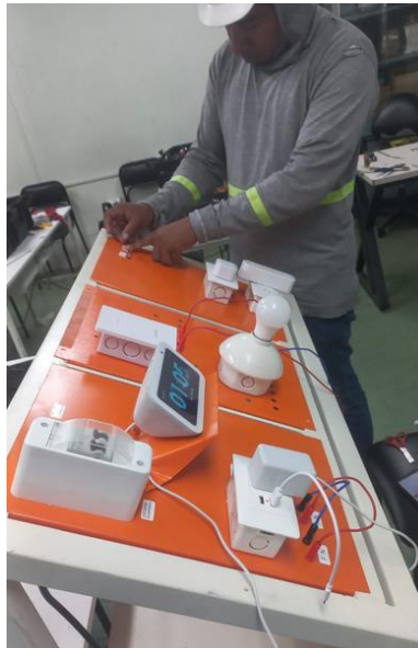
Figura 6. Módulos del tablero utilizados en la carrera de Electricidad.
